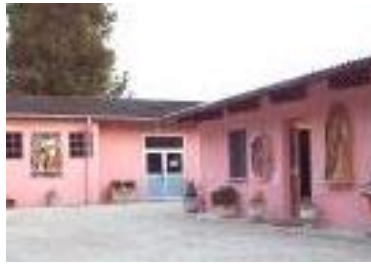
La struttura esterna del Museo del Trotto
